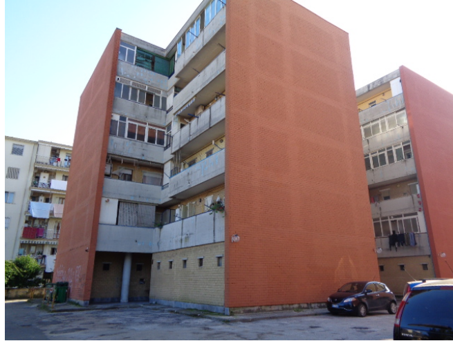
Veduta del fabbricato "A" dall'interno del Parco "California - Nuova Zelanda"
