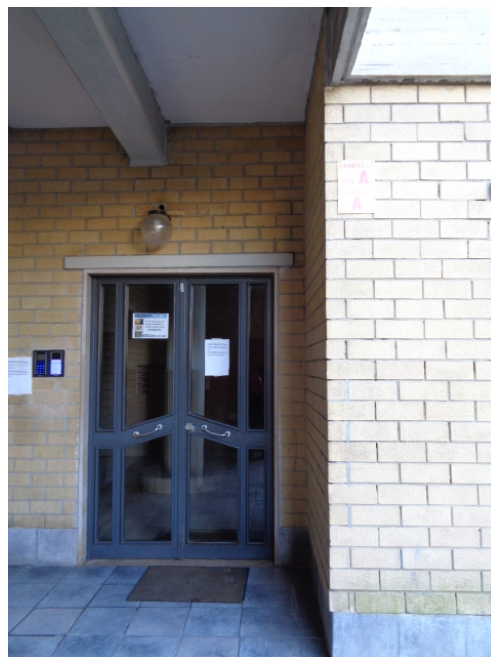
Portone d'accesso al fabbricato A - Scala A
